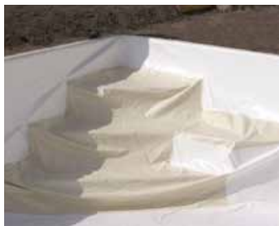
Угловая лестница, укладка лайнера / Corner stairs laying of the liner
